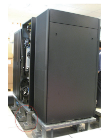
高架地板上電腦機櫃安裝YS-AR抗地震型彈簧式避振器
