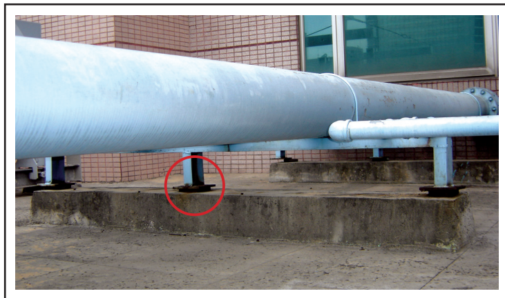
水平管安裝YS-P橡膠墊片
