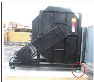
風車安裝YS-Y氣墊式避振器
