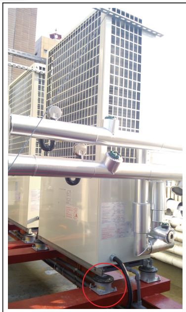
氣冷主機安裝YS-Y氣墊式避振器
