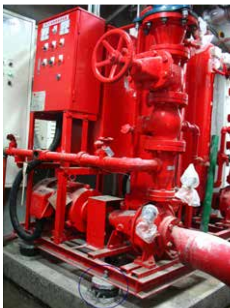
消防泵安裝YS-K氣墊式避振器
