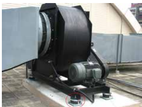
風車安裝YS-K氣墊式避振器
