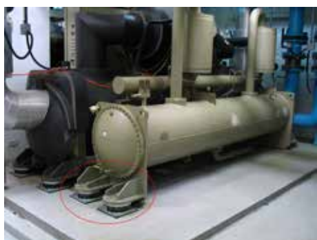
冰機安裝YS-K氣墊式避振器
