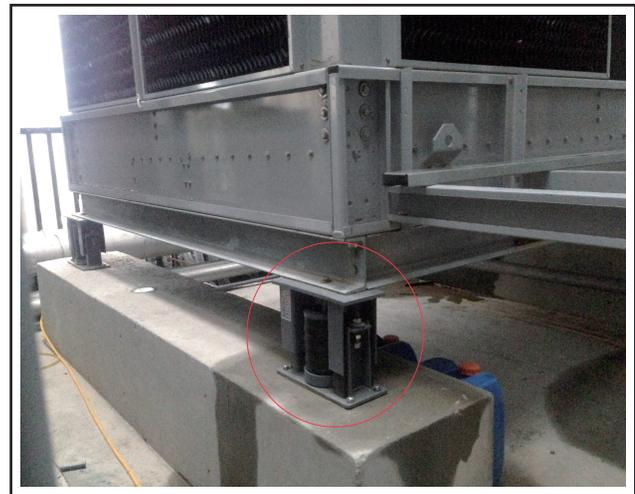
水塔安裝抗震型彈簧橡膠模鑄型避振器
