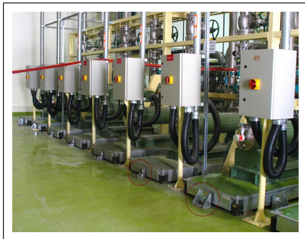
連軸水泵安裝YS-EA橡膠式擊震器
