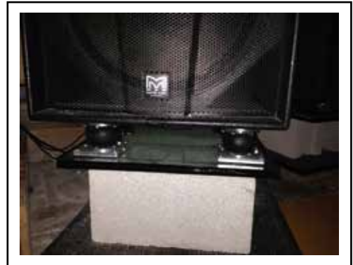
重低音音響安裝YS-K氣墊式避振器
