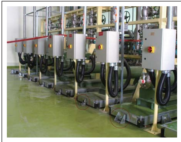
連軸水泵安裝YS-EA橡膠式擊震器
