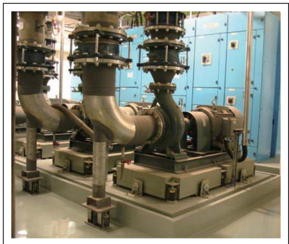
連軸水泵安裝YS-EA橡膠式擊震器
