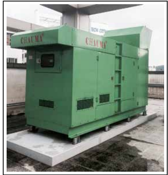
發電機安裝YS-B彈簧式避振器
