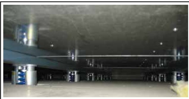
浮動地板安裝YS-B彈簧式避振器
