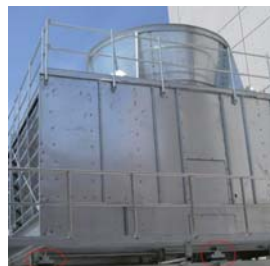
水塔安裝YS-AR抗地震型彈簧式避振器
