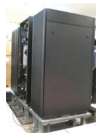
高架地板上電腦機櫃安裝YS-AR抗地震型彈簧式避振器
