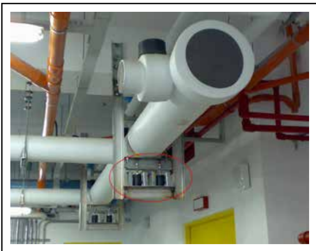
冷卻水管安裝YS-A彈簧式避振器
