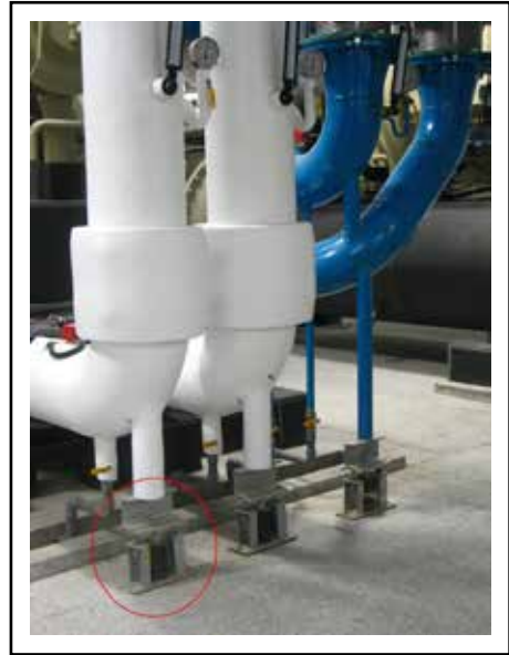
水管支撐安裝YS-A彈簧式避振器
