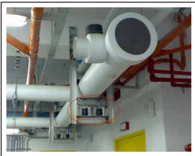
冷卻水管安裝YS-A彈簧式避振器
